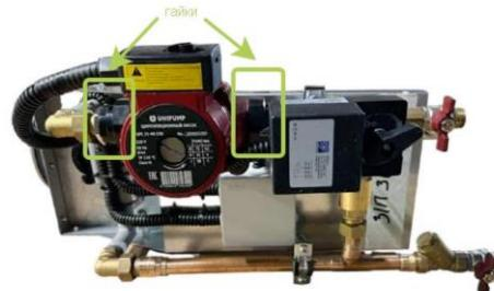
Пример верного положения вент. машины, но **следует повернуть насос**:
